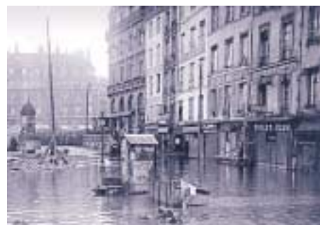
Crue de 1910. Paris, quai des Grands-Augustins
