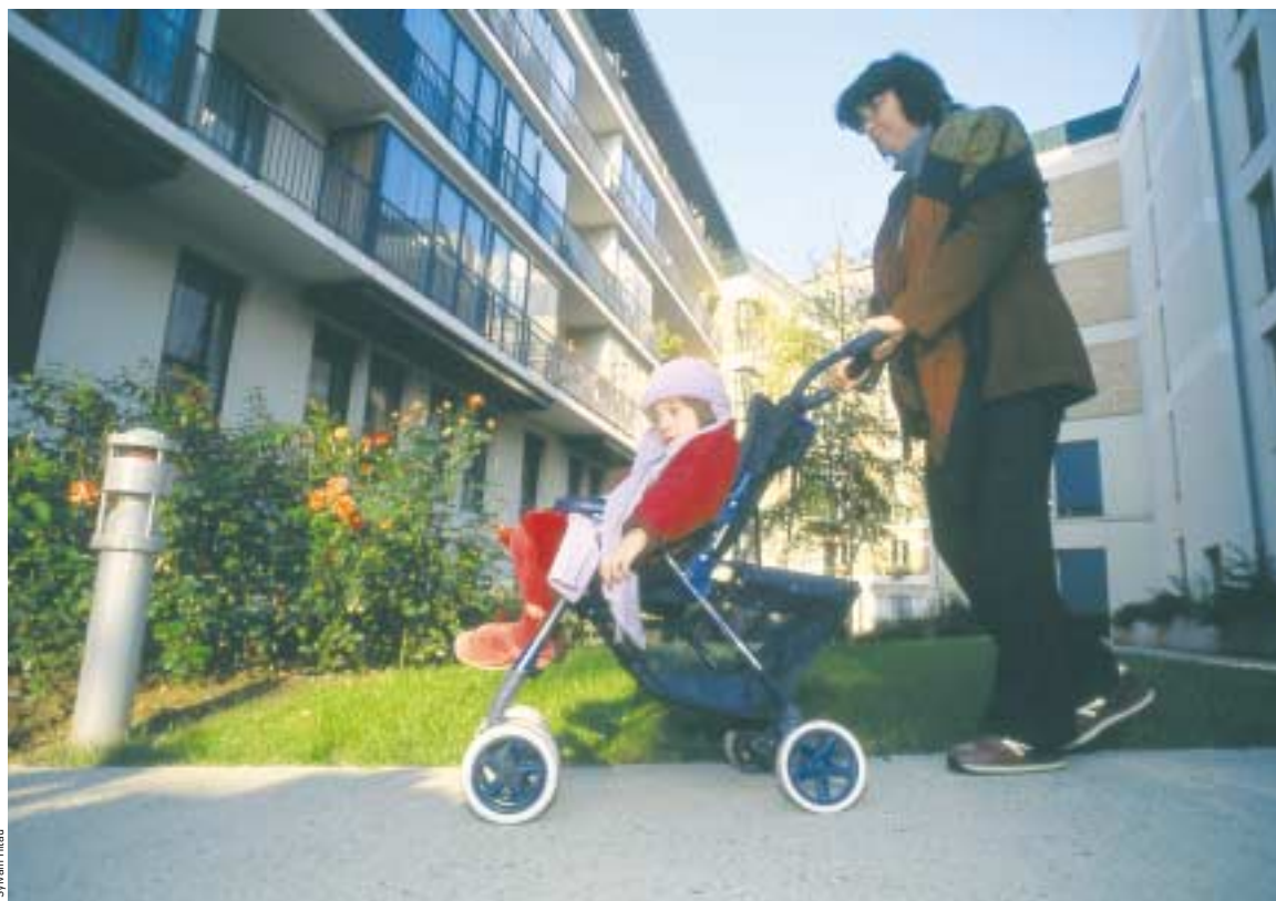
Le 21, rue Joseph de Maistre est entièrement accessible aux personnes à mobilité réduite. Des équipements utiles à l'ensemble des locataires du groupe.
