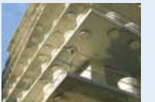
Vue de l'immeuble pendant les travaux.
