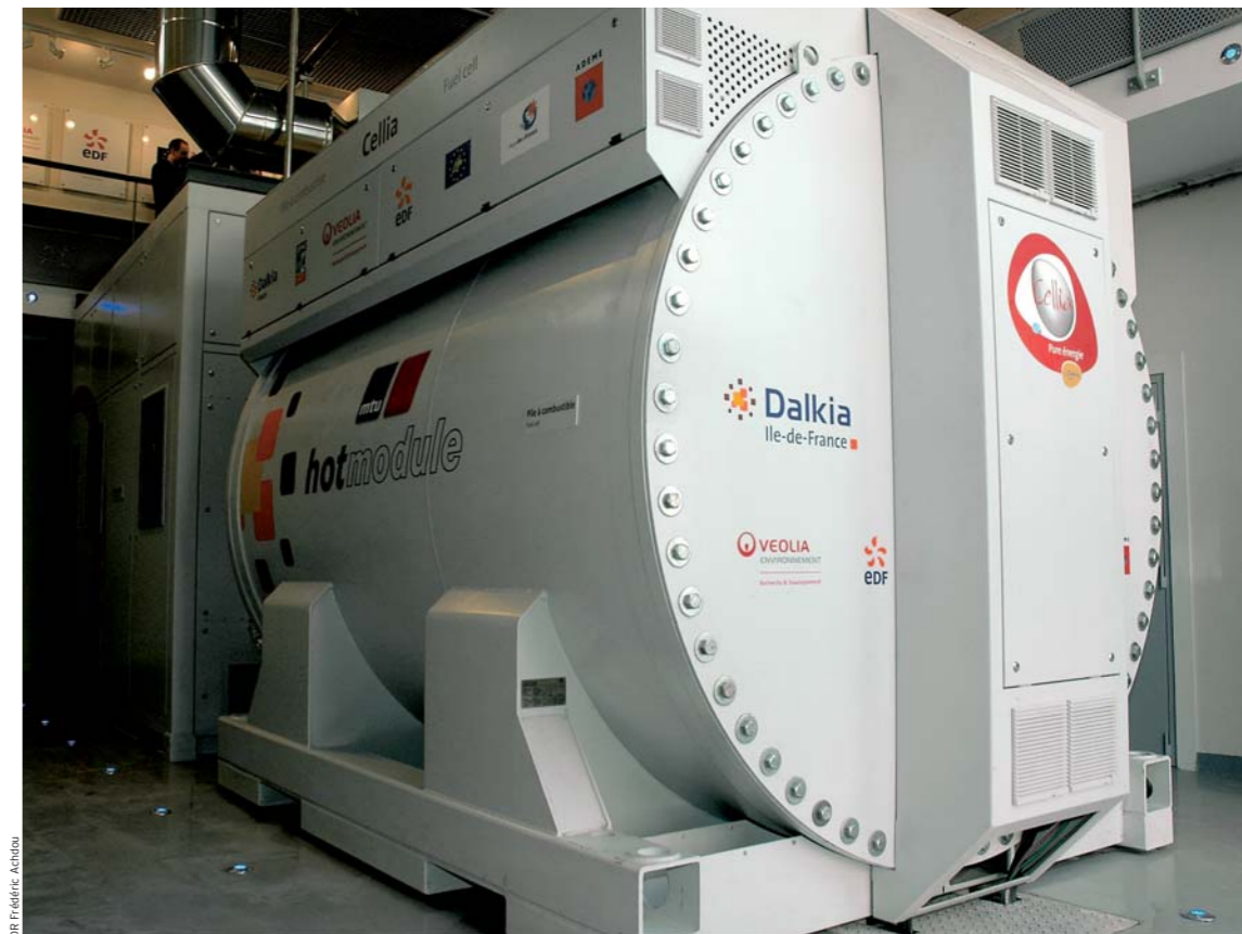
La pile à combustible fera fonctionner une chaufferie expérimentale.
