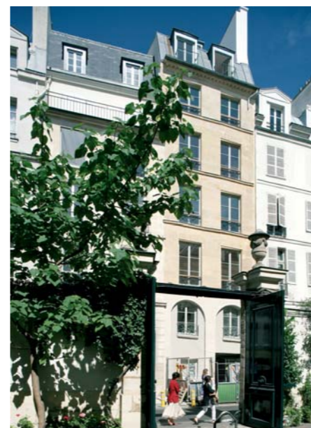
Rue Bonaparte (6 e ), l'ancien bâtiment a été réhabilité.
